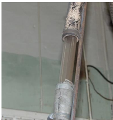
Рис. 6 а. Фрагмент трубопровода
